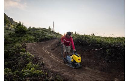
Beim Bau des Flowtrails Wurzenbord wurden ausschliesslich elektrisch betriebene Baumaschinen (Bagger, Dumper, Verdichtungsplatten etc.) verwendet.
